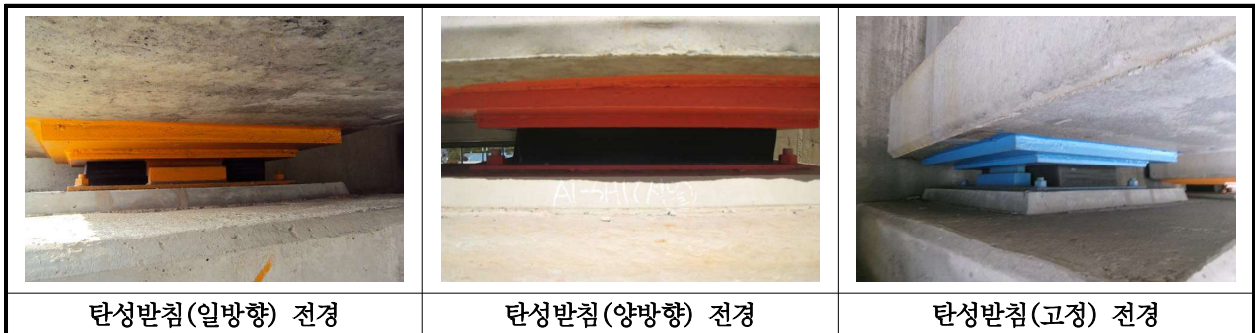
【사진 29.3.10】 교량받침 전경
