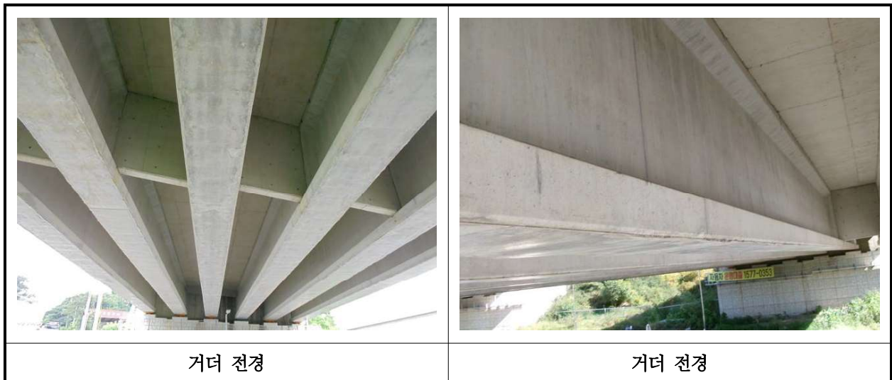
【사진 29.3.4】 거더 전경
