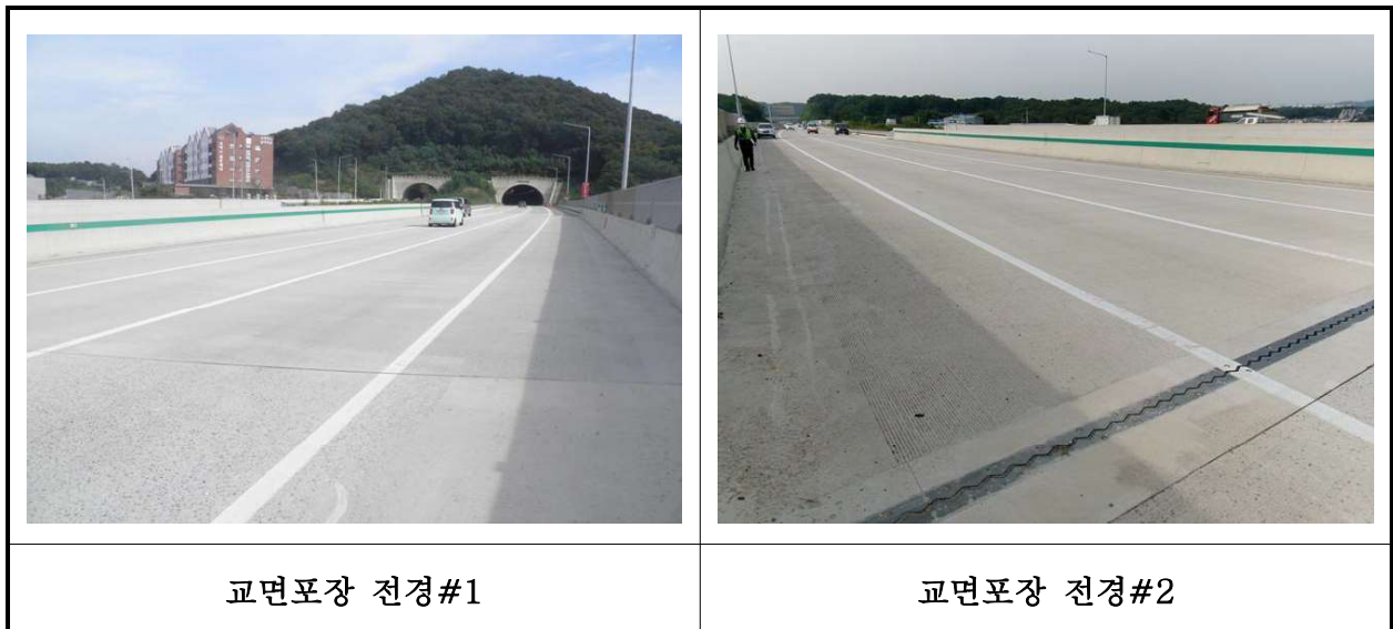
【사진 29.3.16】 교면포장 전경
