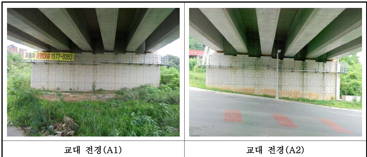
【사진 29.3.8】 교대 전경
