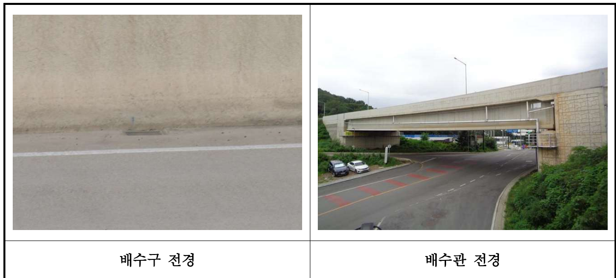
【사진 29.3.18】 배수시설 전경
