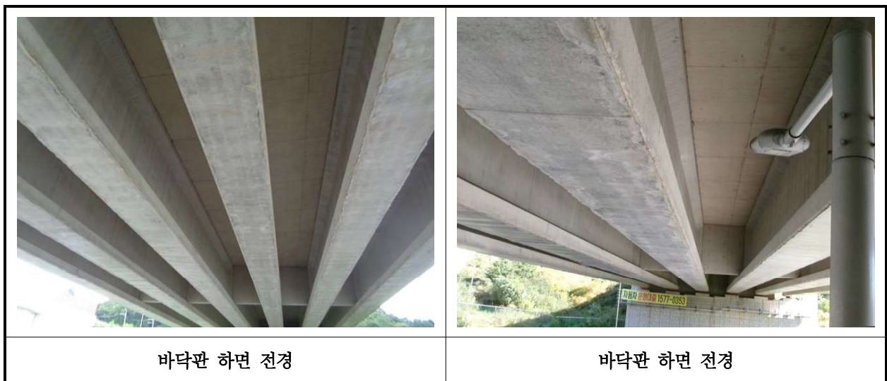
【사진 29.3.2】 바닥판하면 전경
