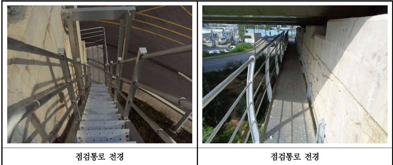
【사진 29.3.22】 교량 점검시설 전경
