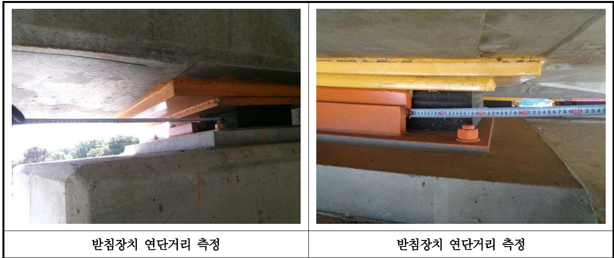
【사진 29.3.12】 교량반침장치 연단거리측정
