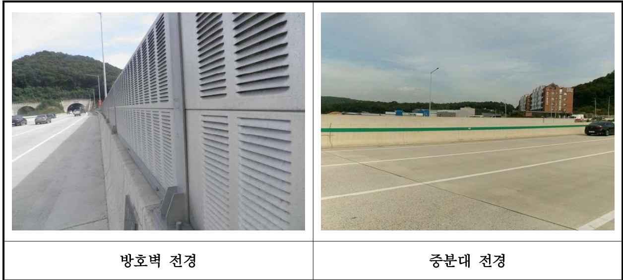
【사진 29.3.20】 방호벽 및 중앙분리대 전경
