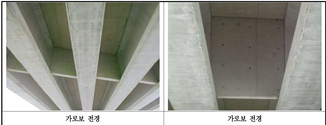
【사진 29.3.6】 가로보 전경
