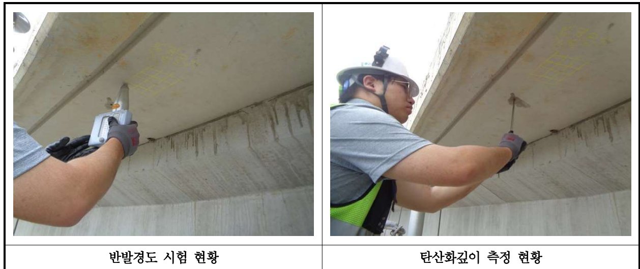
【사진 29.4.1】 콘크리트 내구성조사 현황
